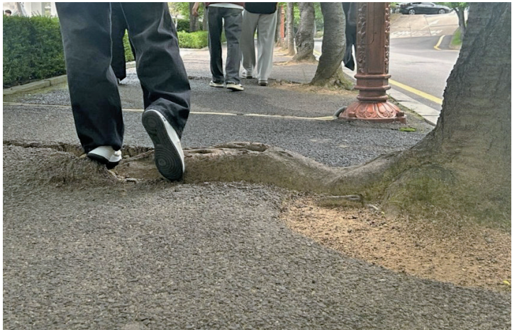
답압으로 인해 가로수 뿌리가 보행로를 가로질러 지면으로 드러났다.
