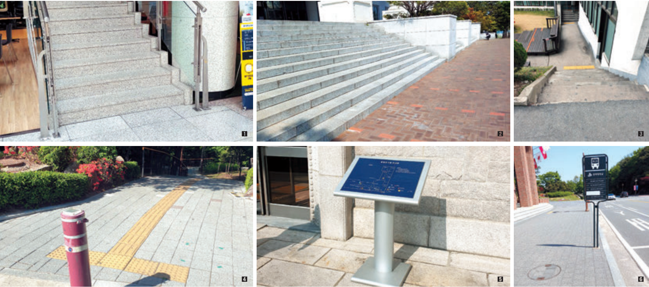
1 내부 계단에 점자블록이 설치되지 않은 모습이다. 2 예술디자인대 외부 입구 계단에 점자블록이 없는 모습이다. 3 정경대의 점형 블록은 계단 한쪽에만 존재해 시작과 끝을 알 수 없다. 4 차량 진입 방지용 볼라드가 통행을 방해한다. 5 점자 안내도 까지 이어진 유도 및 점형 블록이 없어 안내도가 제 기능을 하지 못한다. 6 ‘교통약자의 이동편의 증진법’에 따르면 정류장에도 블록이 설치돼야 하지만 국제캠 내 5개의 버스정류장에는 블록이 존재하지 않는다.
