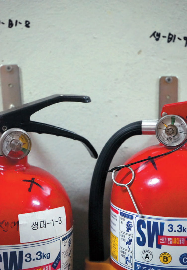
생명대학관 지하 1층. 제조일 2000년 소화기의 기압바늘이 정상사용범위를 벗어났다. 제조일 2013년 소화기의 안전핀은 뽑혀있다.
