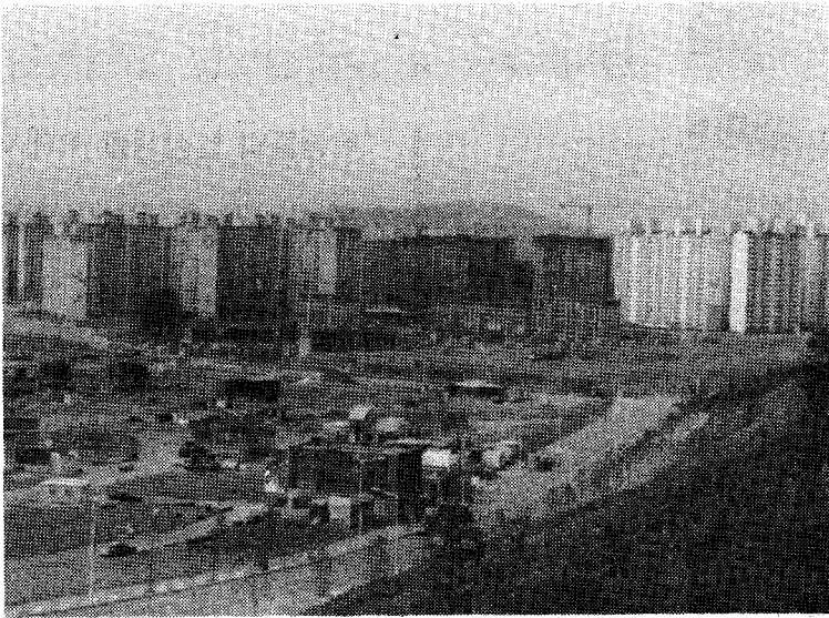
▲10만명이 거주하게 될 아파트 공사 부지
