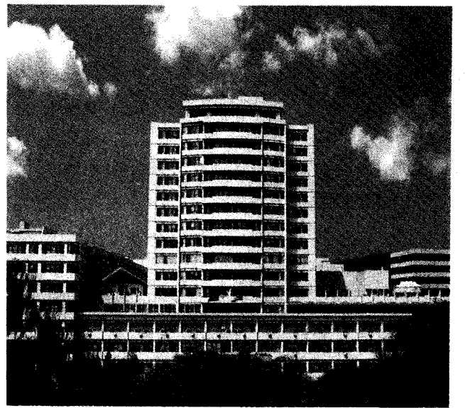
▲조선왕조 9대 성종의 왕비이며 연산군의 친모인 폐비 윤씨의 묘가 있던 경희의료원.
