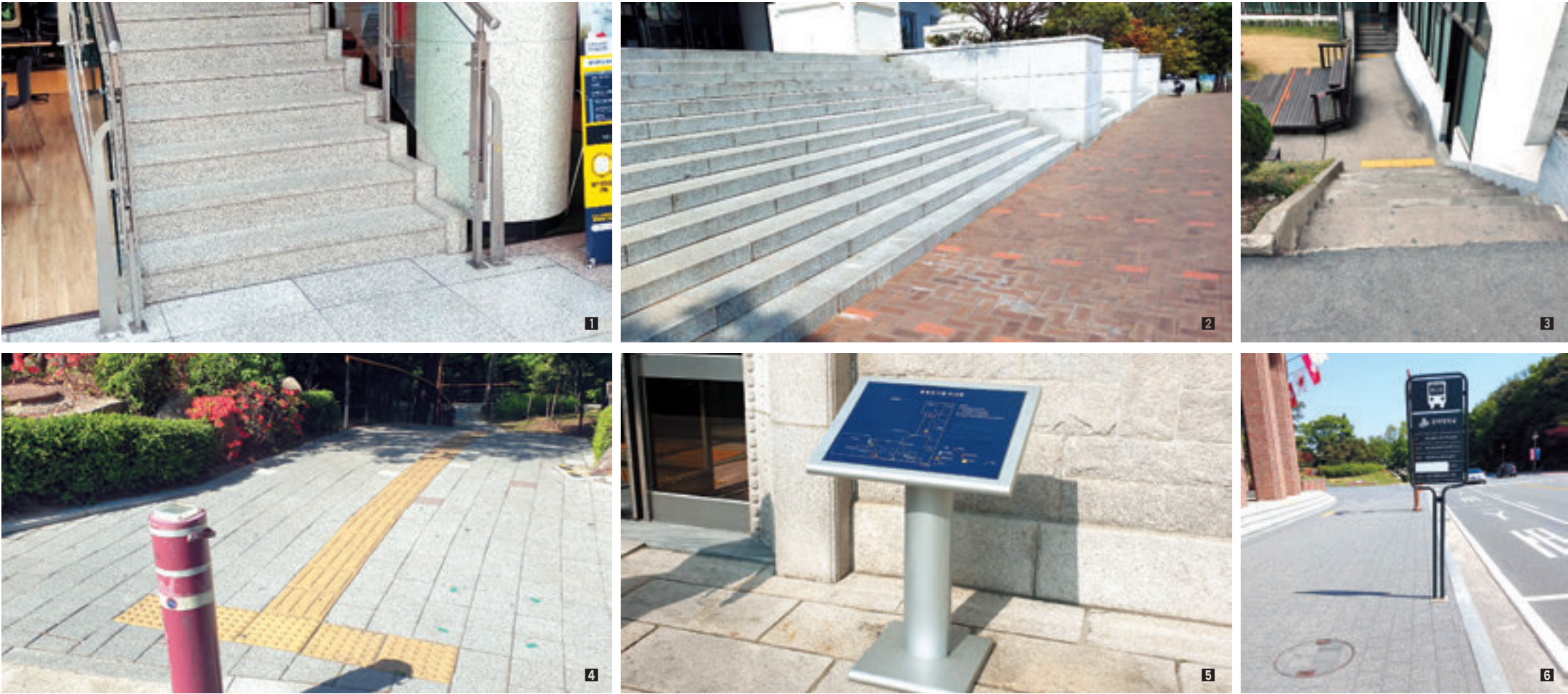
❶ 내부 계단에 점자블록이 설치되지 않은 모습이다. ❷ 예술디자인대 외부 입구 계단에 점자블록이 없는 모습이다. ❸ 정경대의 점형 블록은 계단 한쪽에만 존재해 시작과 끝을 알 수 없다. ❹ 차량 진입 방지용 볼라드가 통행을 방해한다. ❺ 점자 안내도 까지 이어진 유도 및 점형 블록이 없어 안내도가 제 기능을 하지 못한다. ❻ ‘교통약자의 이동편의 증진법’에 따르면 정류장에도 블록이 설치돼야 하지만 국제캠 내 5개의 버스정류장에는 블록이 존재하지 않는다.
